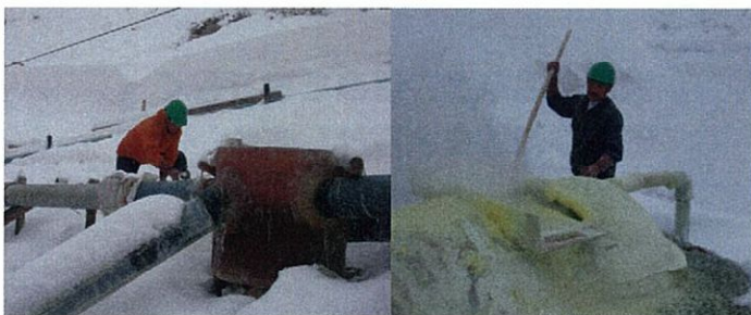
パイプに付着した硬いスケールの除去作業
